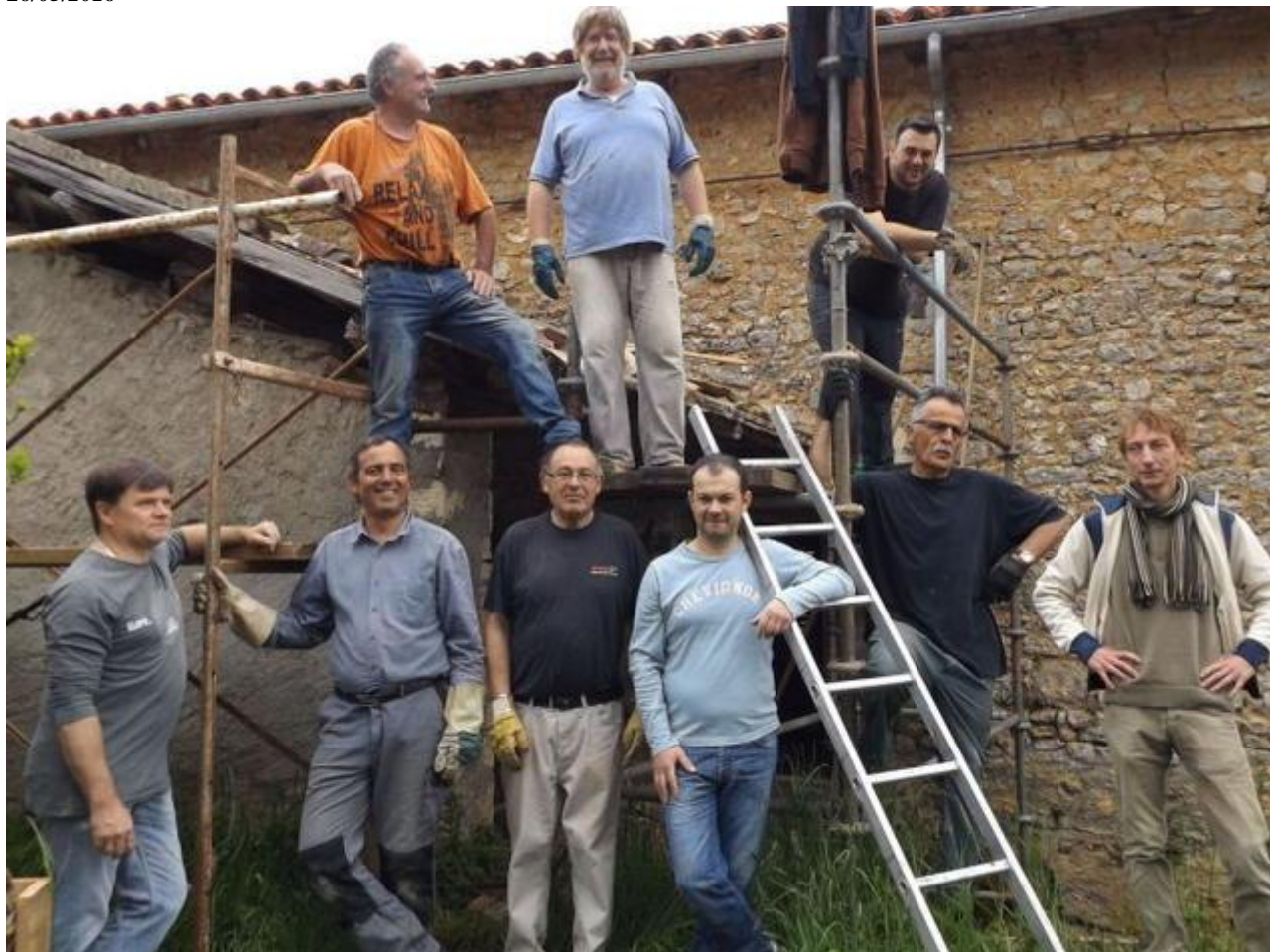
Première étape : réfection de la toiture de la roue.
